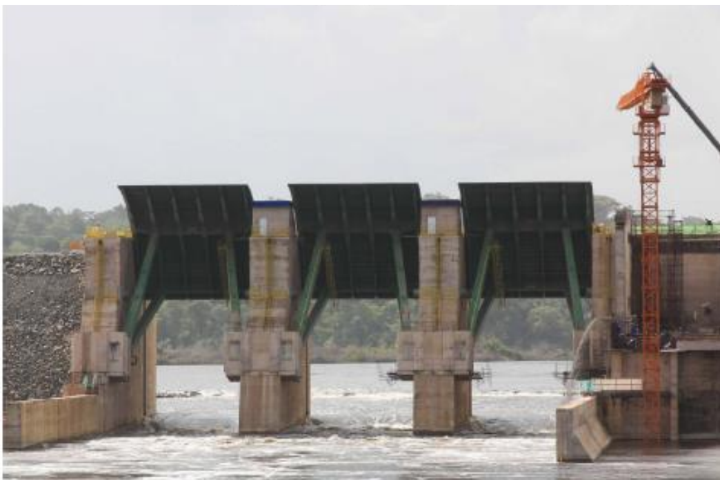
Imagem 18. Seção a Jusante das Três Comportas do Vertedouro, em Posição Aberta (06 de janeiro de 2014)
