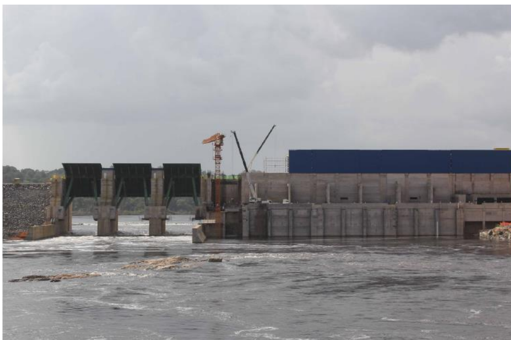
Imagem 2. Vista da Usina Hidrelétrica a Jusante do Rio em 6 de janeiro de 2014
