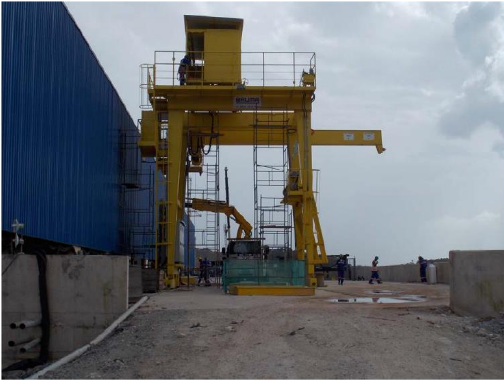
Imagem 10. Parede montante da Casa de Energia e Guindaste para a Movimentação de Comportas Ensecadeiras de Entrada (06 de janeiro de 2014)
