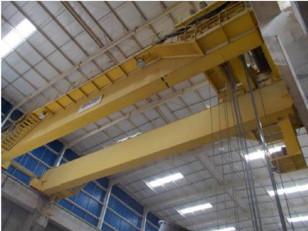
Imagem 16. Guindaste da Casa de Força Sendo Utilizado na Unidade 1(6 de janeiro de 2014)
