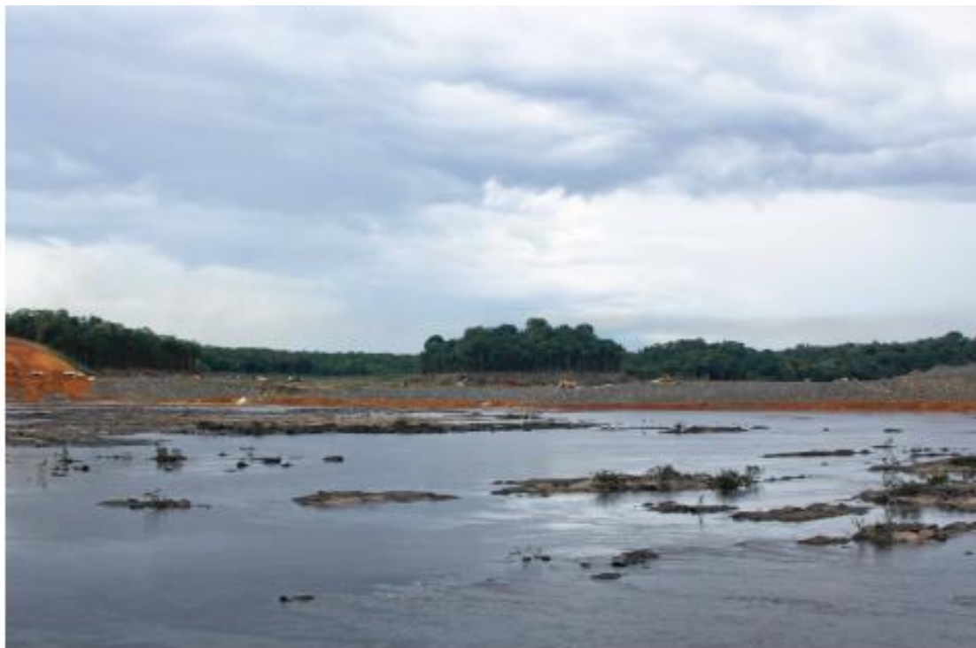
Imagem 19. Seção a Jusante da Barragem (06 de janeiro de 2014)
