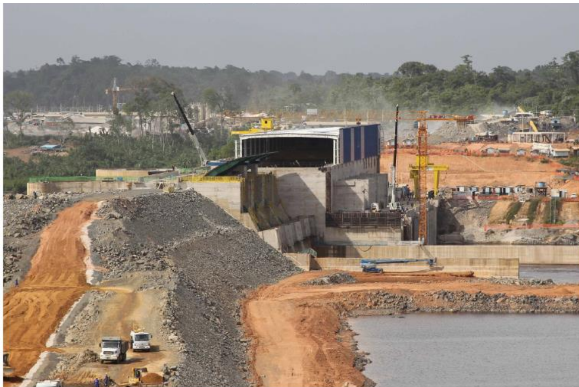
Imagem 6. Vista da Casa de Força da Margem Direita (06 de janeiro de 2014)
