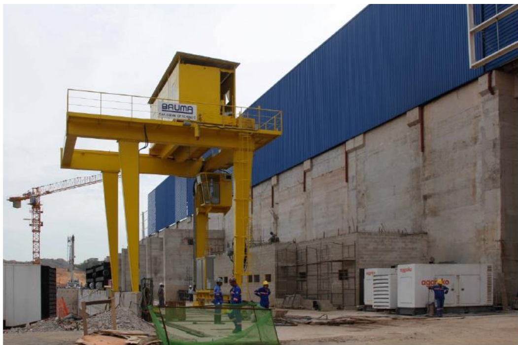
Imagem 8. Parede jusante da Casa de Energia e Guindaste para a Movimentação de Comportas Ensecadeiras do Tubo de Sucção
