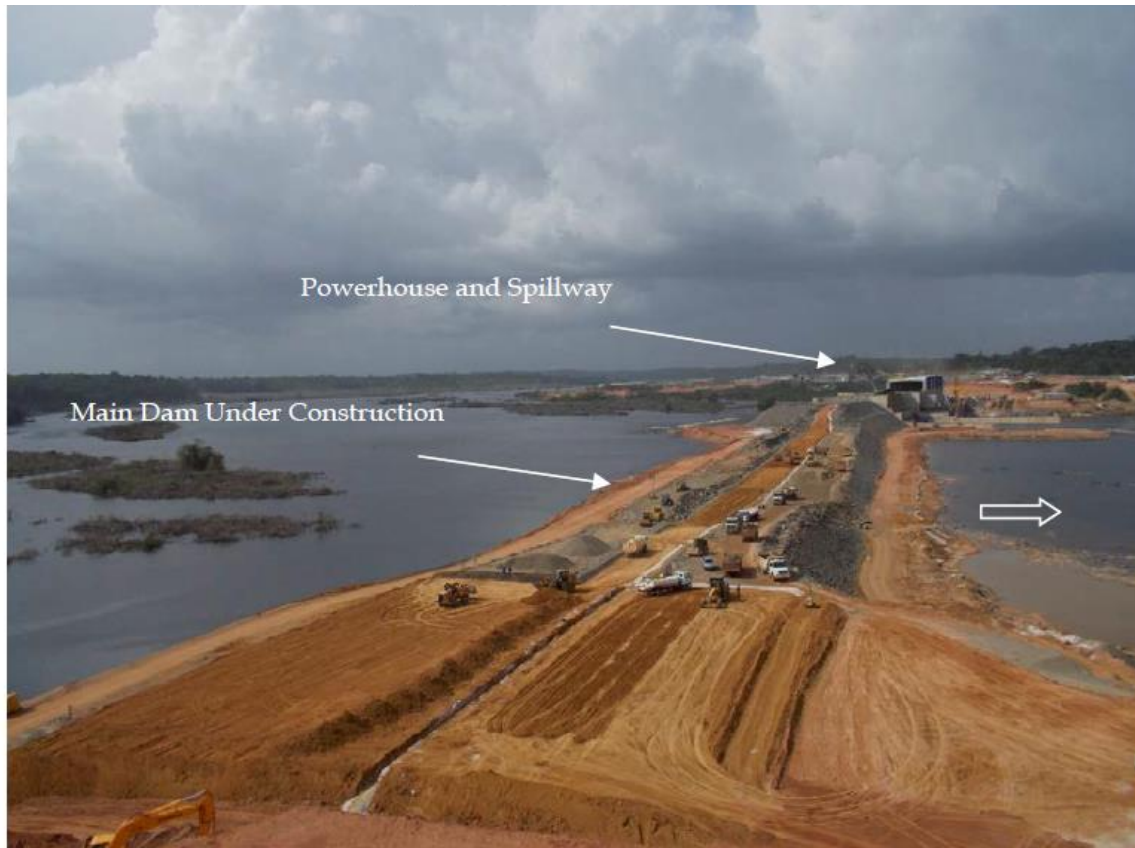
Imagem 4. Vista do Canteiro de Obras da Margem Direita (06 de janeiro de 2014)
