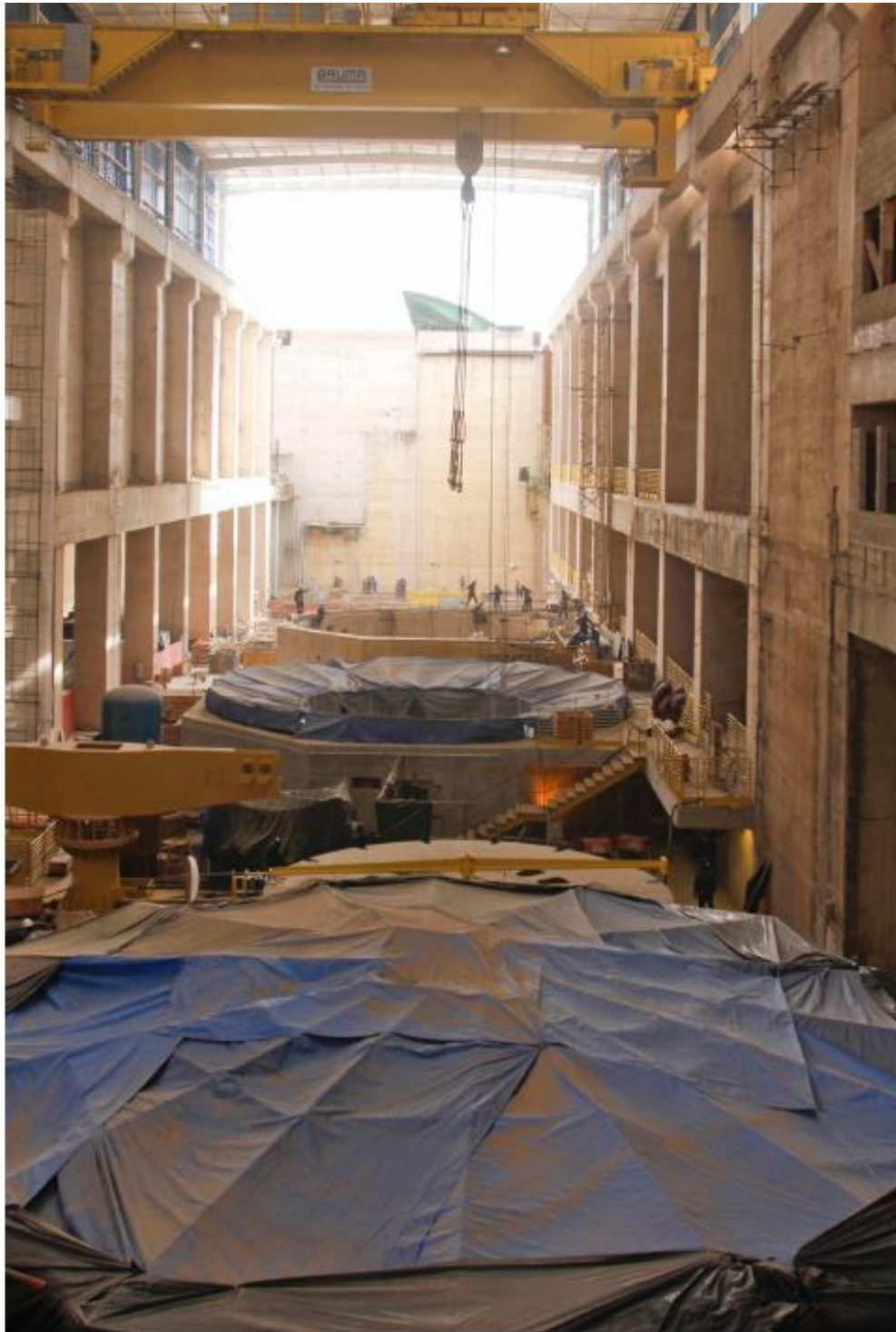
Imagem 12. Interior da Casa de Força Voltado Para a Parede Esquerda (6 de janeiro de 2014)
