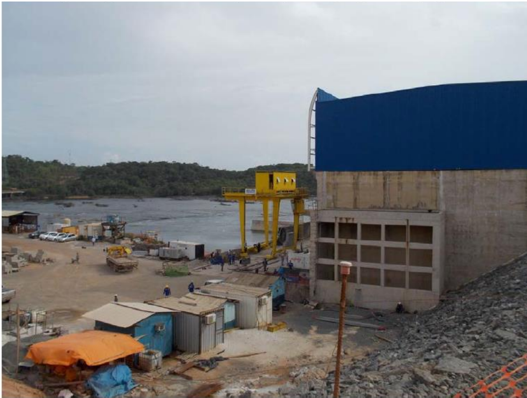
Imagem 7. Parede esquerda da Casa de Energia e Guindaste para a Movimentação de Comportas Ensecadeiras do Tubo de Sucção (06 de janeiro de 2014)
