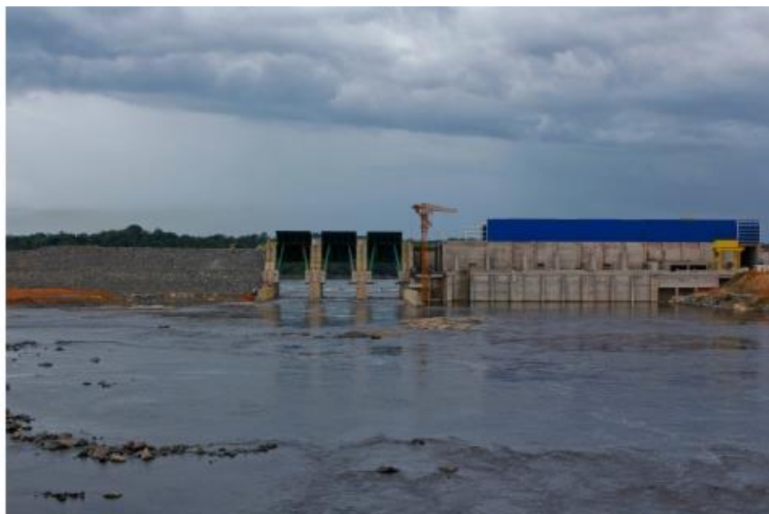
Imagem 20. Seção a Jusante da Usina Hidrelétrica (06 de janeiro de 2014)
