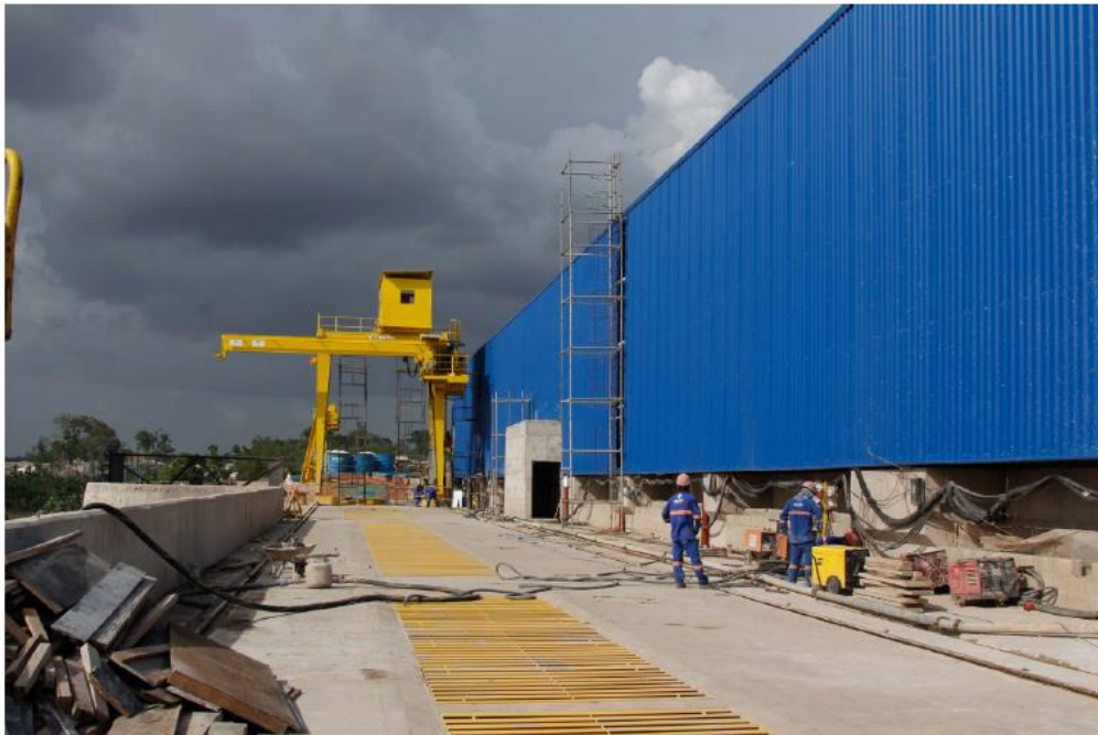
Imagem 10. Parede montante da Casa de Energia e Guindaste para a Movimentação de Comportas Ensecadeiras de Entrada (06 de janeiro de 2014)
