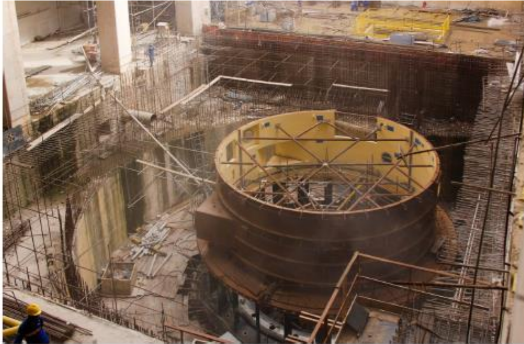
Imagem 15. Unidade de Potência 3 (6 de janeiro de 2014)
