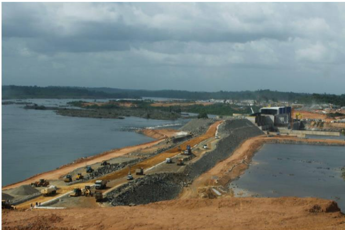
Imagem 5. Vista do Canteiro de Obras da Margem Direita (06 de janeiro de 2014)
